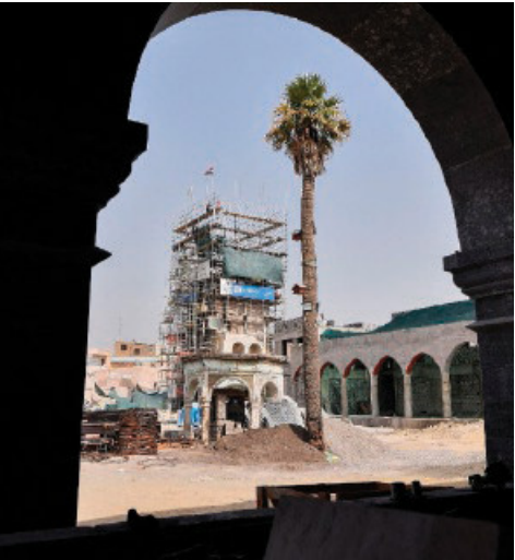
Un intervento di ricostruzione a Mosul
