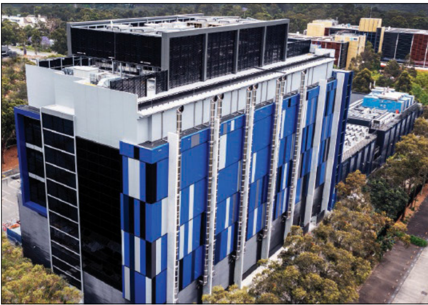
Un data center a Sydney
