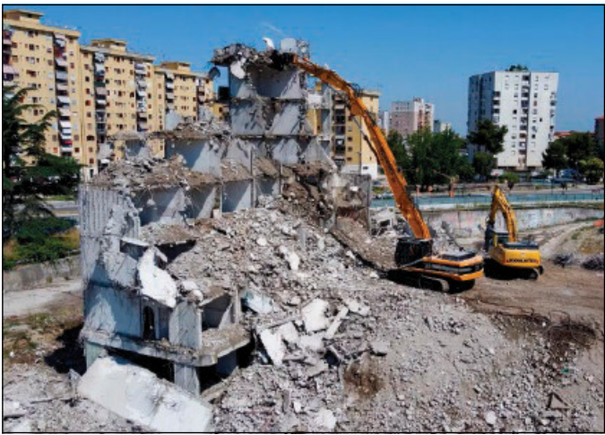
La Vela Verade di Scampia in demolizione (2020)
